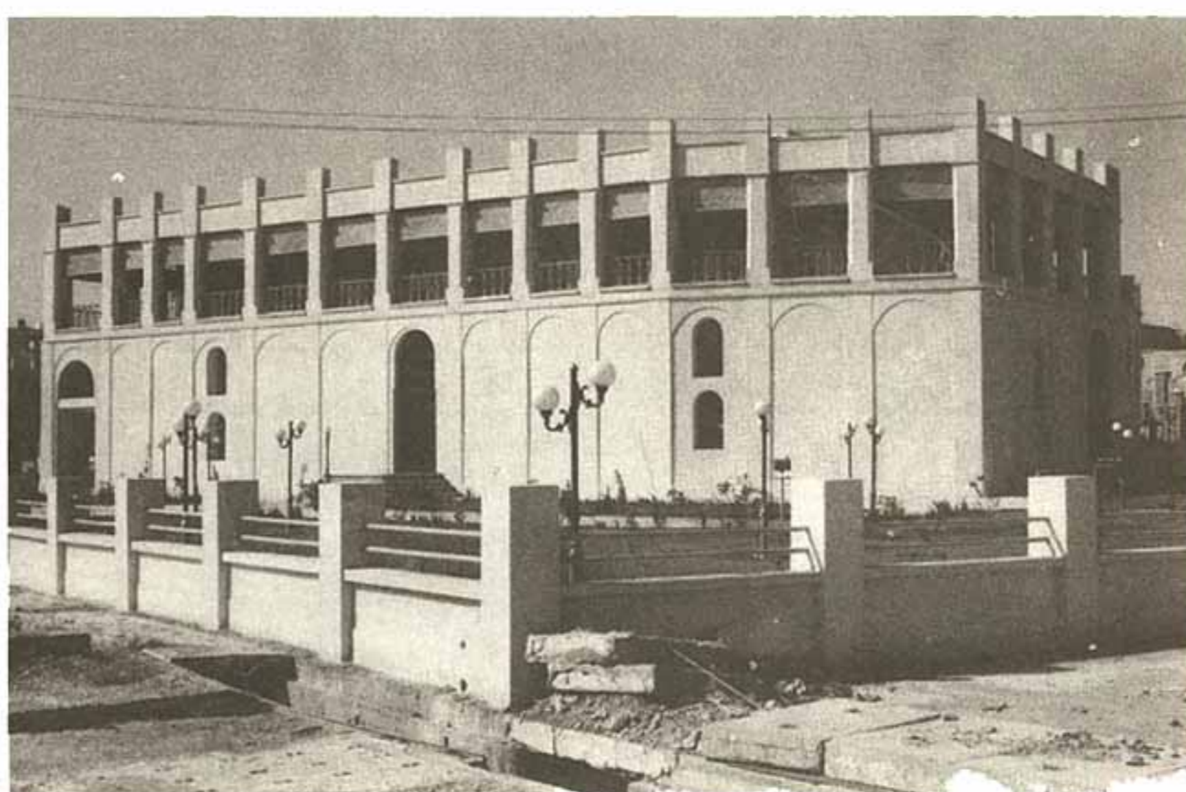
طرح مرمت ساختمان کازرونی، بوشهر / طرح : محمد مهدی محمودی / همکاری با مهندسین مشاور هرم پی
